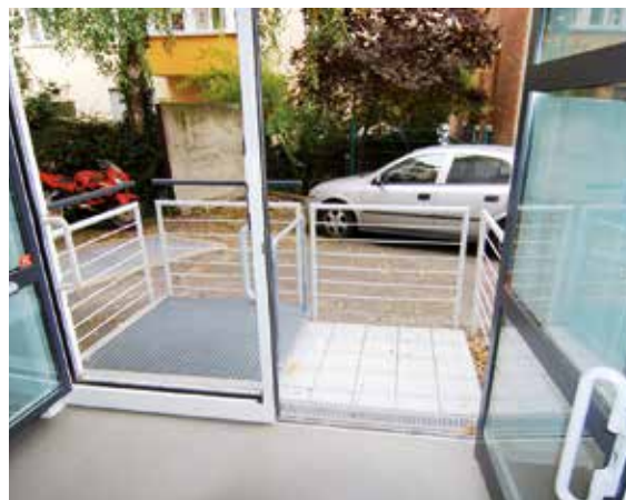
Niveaugleiches Austrittspodest und angeschlossene Hubplattform
