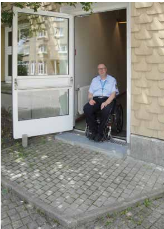
Niveaugleiches Austrittspodest und angeschlossene Hubplattform
