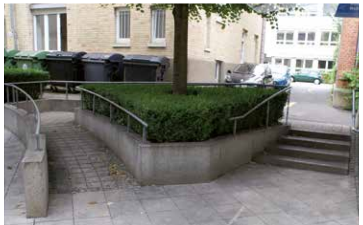
Rampe, die an derselben Zugangssituation endet wie die entsprechende Treppe
